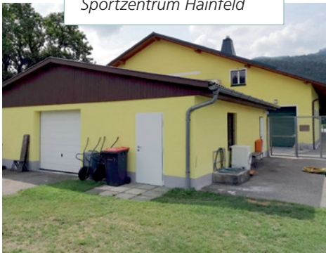
Sanierung Gerätehaus im Sportzentrum Hainfeld
